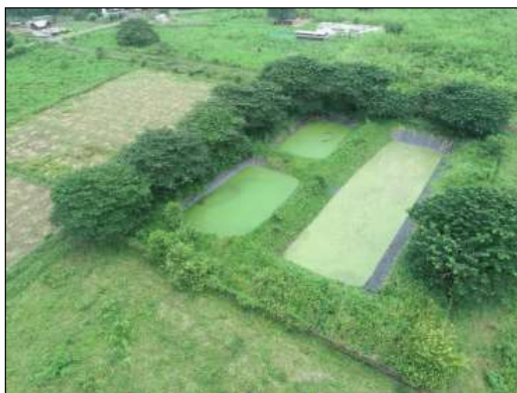
Figura 38. Vista aérea de la Laguna de oxidación ubicada en la parroquia Noboa.
